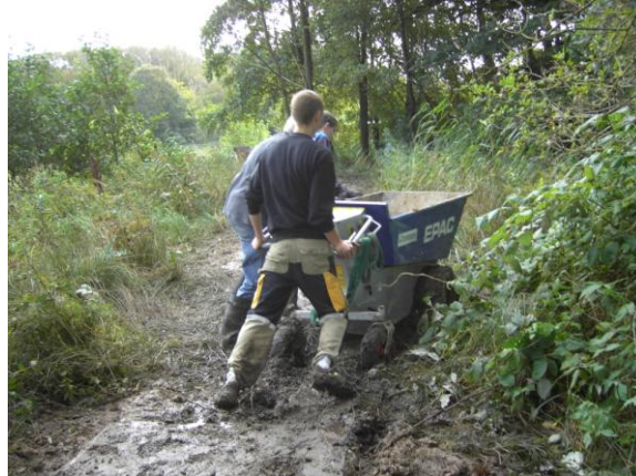
Tungt arbejde i mudder.
